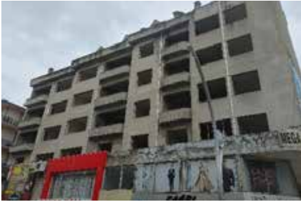
Yıkım Öncesi Riskli Bina
