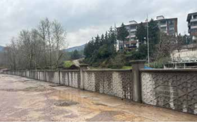
Yeni atık Merkezi İhata Duvarı
