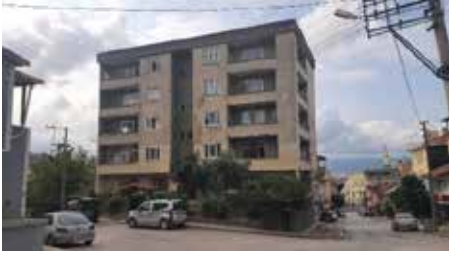
Yıkım Öncesi Hasarlı Bina
