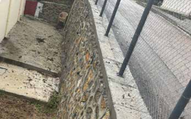
Çınarlı Mah. Yalçın Sokak Taş Duvar İmalatı
