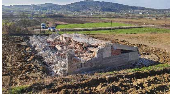
Kaçak Yapı Yıkım
