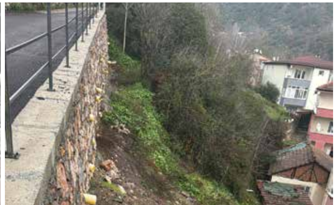
Çınarlı Mah. Oluk Sokak Taş Duvar İmalatı
