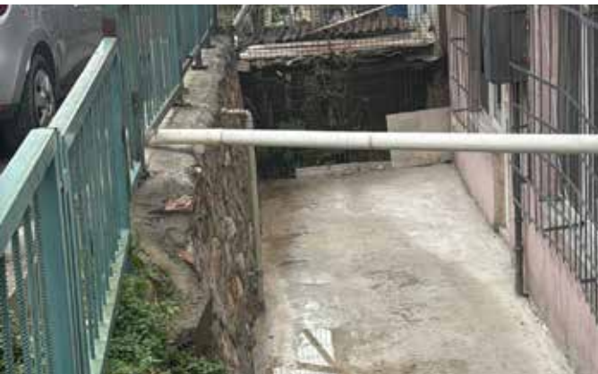
Sırıpaşa Mah. Çimenli Sokak Taş Duvar İmalatı
