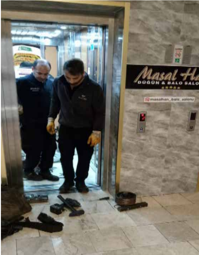
Kasım Ayı 9 Adet Asansöre Ait Aylık Bakım Tutanakları
