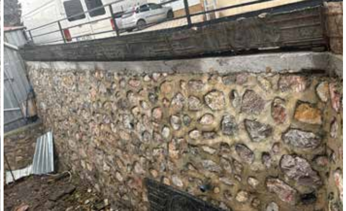
Çınarlı Mah. Onaran Sokak Taş Duvar İmalatı
